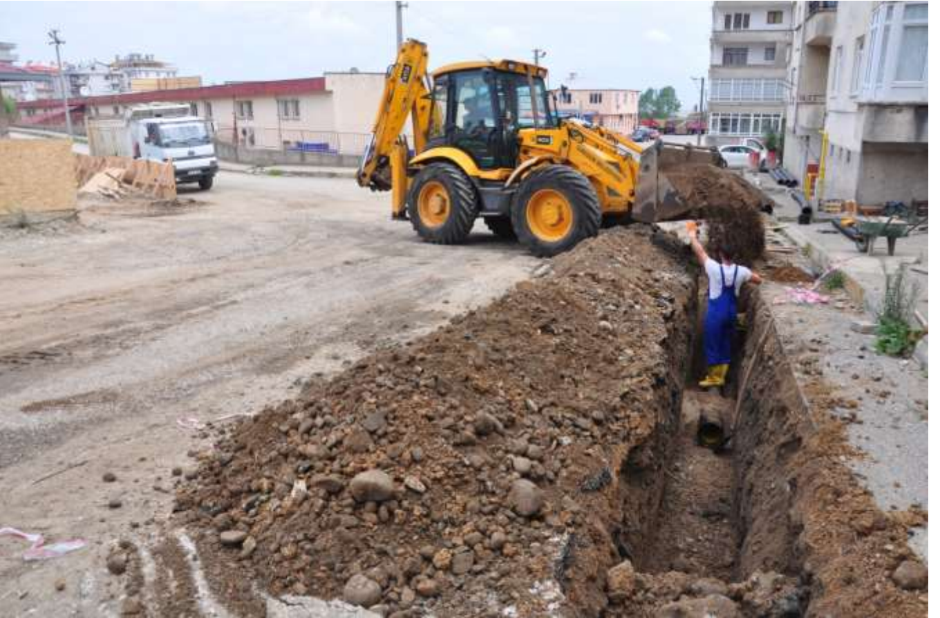
24) Gedikkaya Mah. Ercan Sok. da kanalizasyon ve yağmur suyu şebeke hattı yapımı.
