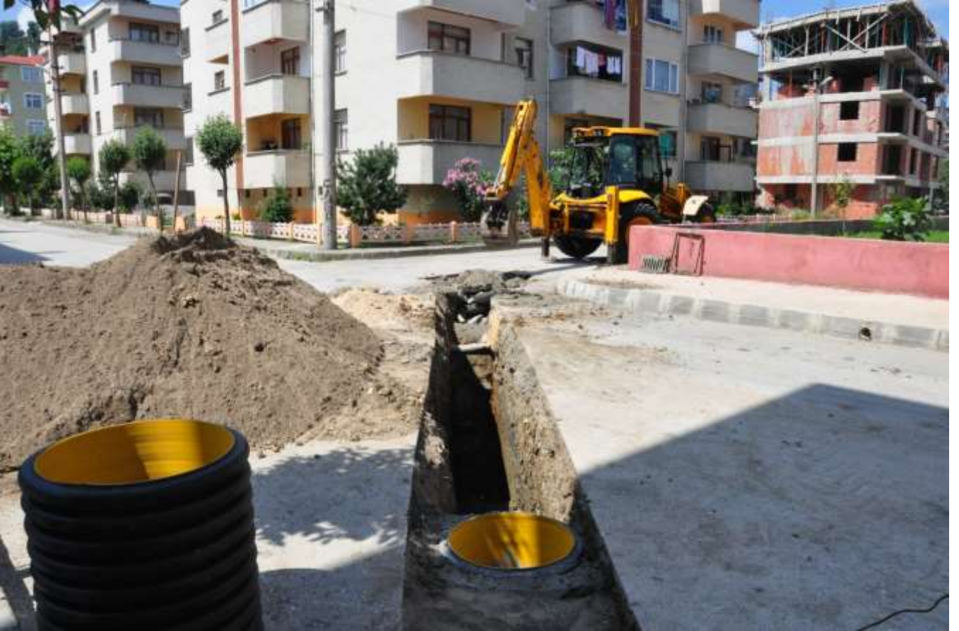
66) Teyyaredüzü Mahallesi 140,141,142,143,144 Nolu Sokaklarda, Ünsal Sok. da, Yüksel Sok. da ve Boztekke Cad.de yağmur suyu şebeke hattı çalışması.
