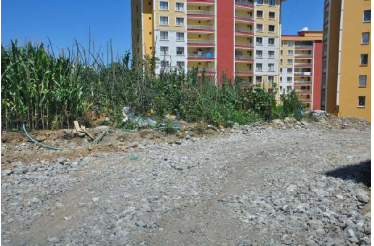
9.TEYYAREDÜZÜ MAHALLESİ BATLAMA SANAYİ CADDESİ(50 mt)
