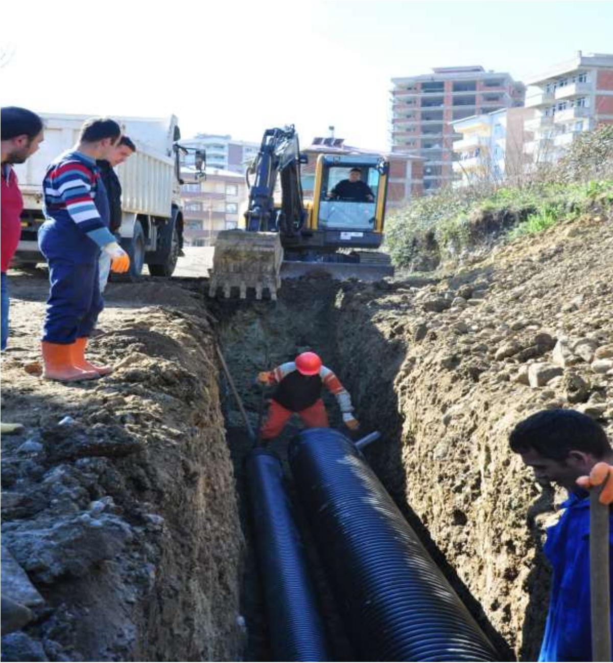
22) Gedikkaya Mah. 95 Nolu Sok. ve Kardelen Sok. larda yağmur suyu hattı yapımı.
