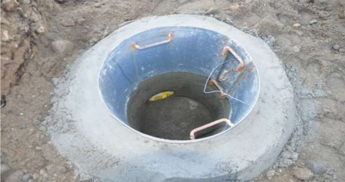
21) Gedikkaya Mah. Nihatbey Cad. ve Şht. Muammer DUR Sok. da kanalizasyon ve yağmur suyu hattı yapımı.
