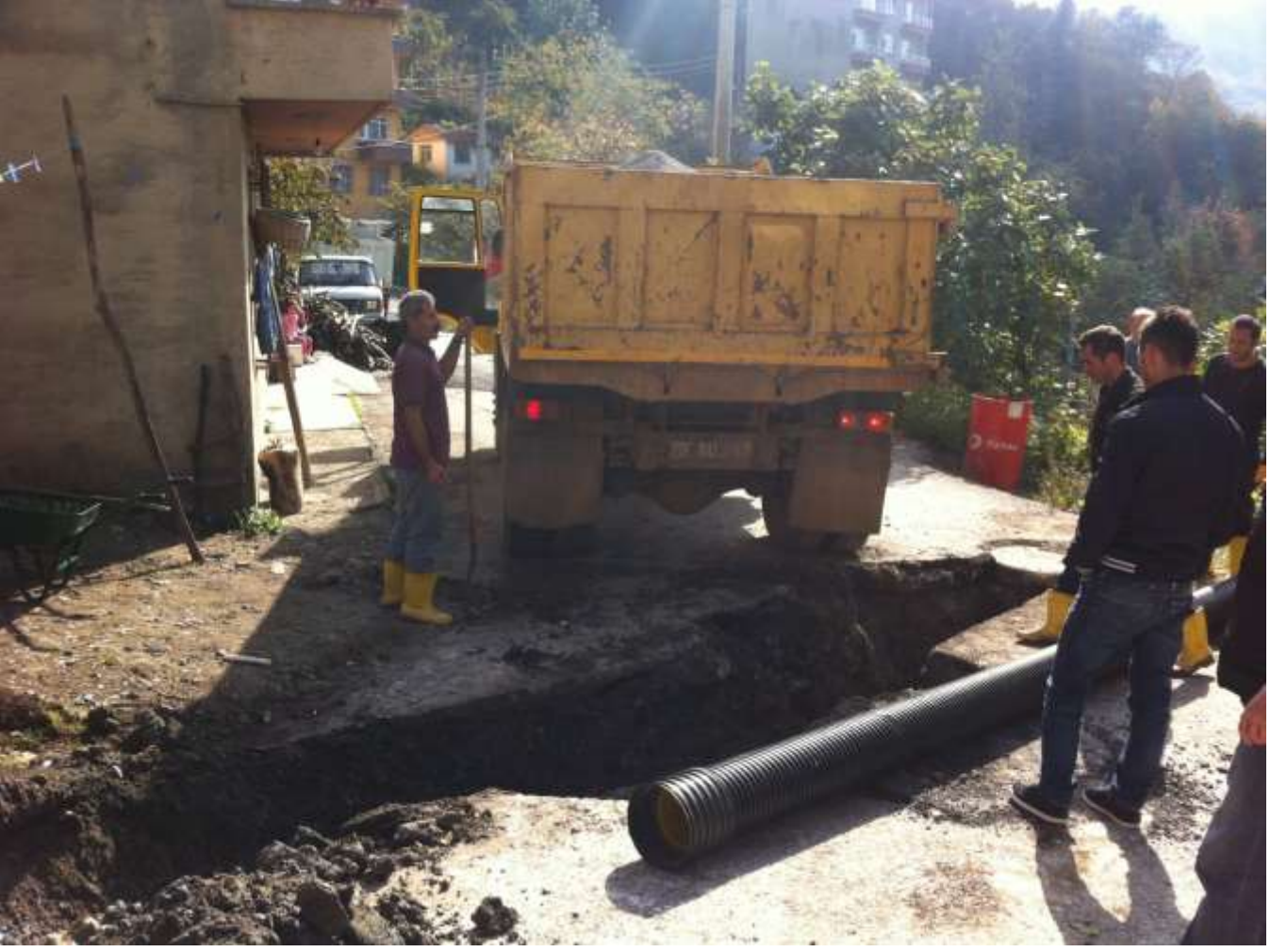
40) ıtlakkale Mahallesi Stadyum Sok. da, Akın Sok. da, Avize Sok. da, Hanımeli Sok. da, Sarmaşık Sok. da, Sönmez Cad. de yağmur suyu Őebeke hattı yapılması.
