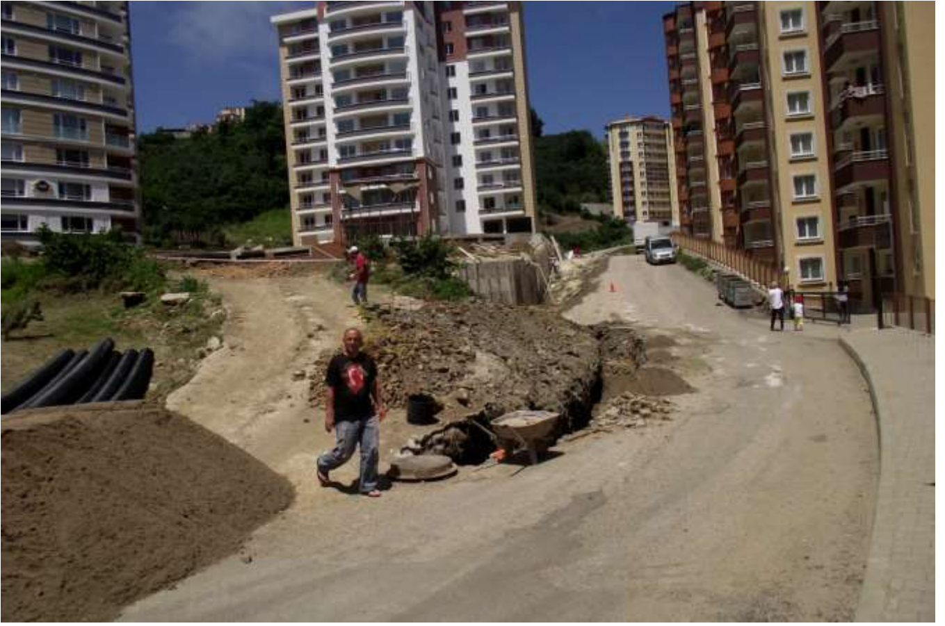
21) Gedikkaya Mah. Nihatbey Cad. ve Şht. Muammer DUR Sok. da kanalizasyon ve yağmur suyu hattı yapımı.
