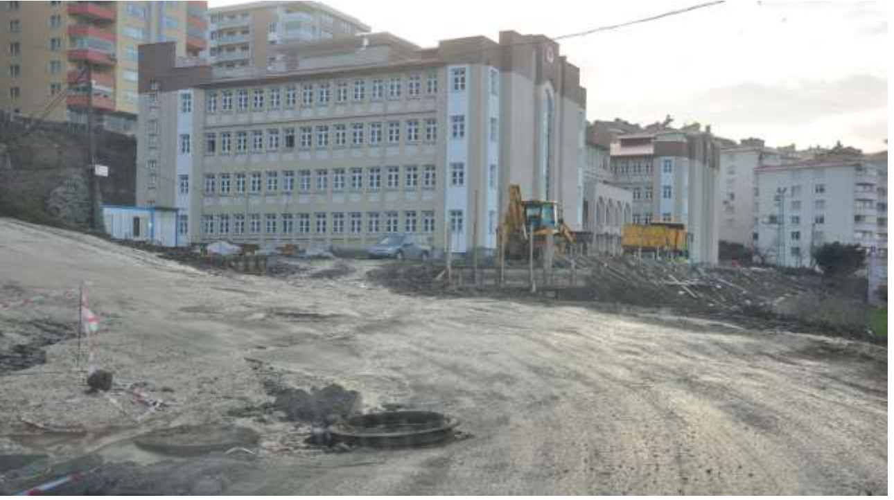
23) Gedikkaya Mah. Kaya Ekmekçi Sok. da kanalizasyon hattı yapımı.
