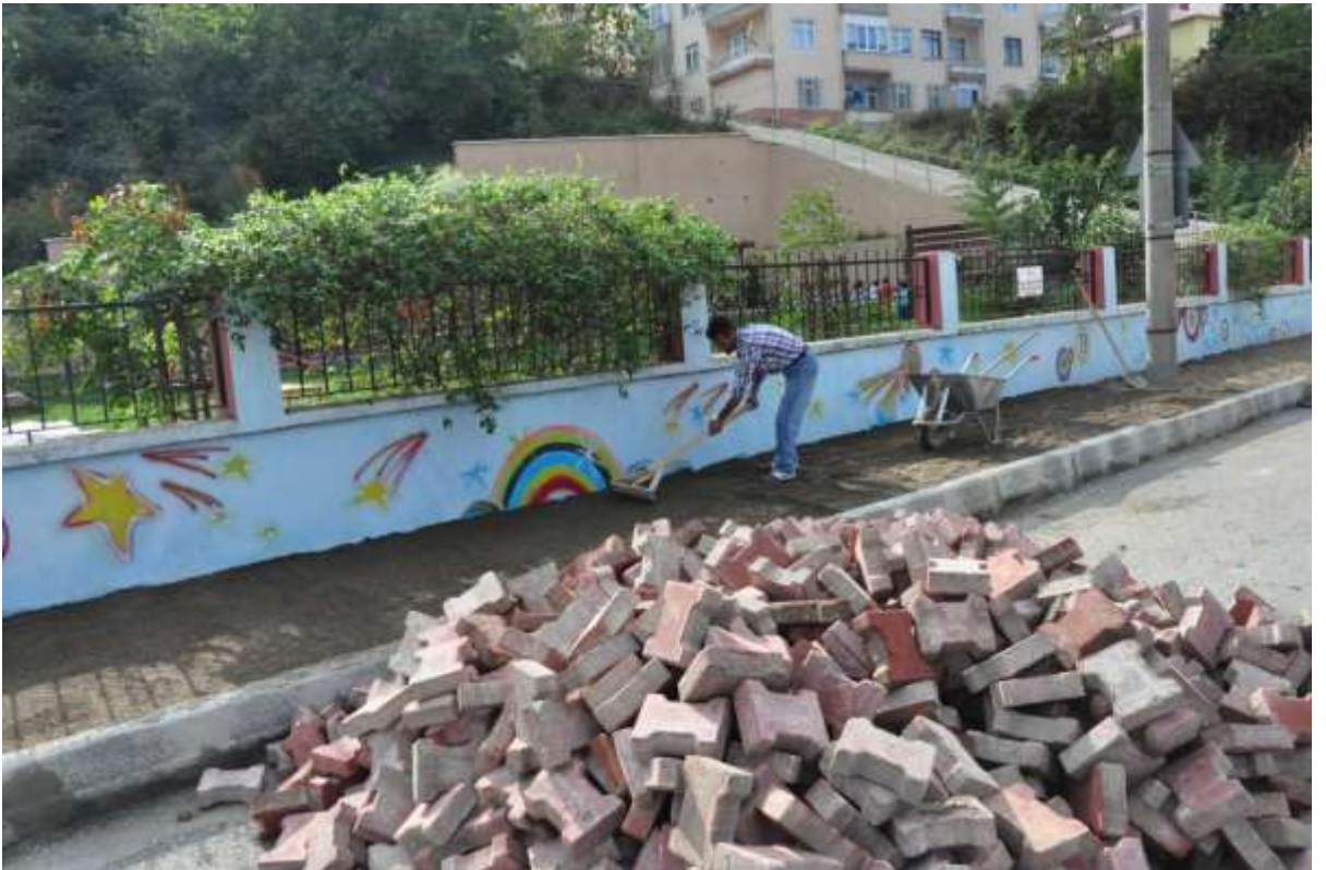
11.DEBBOY MEVKİİ PARKE YENİLEME ÇALIŞMASI
